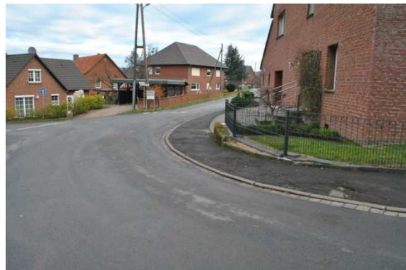
Blick in die Weserberglandstraße
