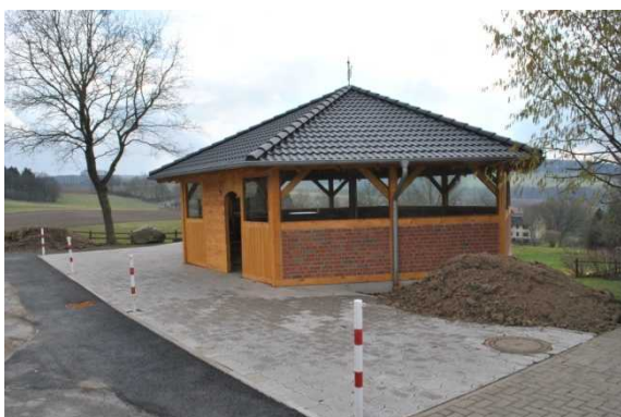
Neuer Unterstand beim Feuerwehrhaus
