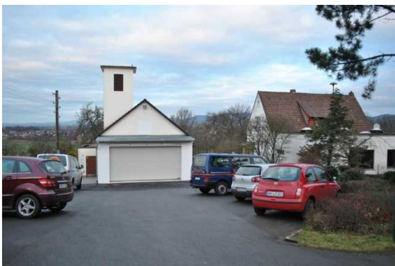
Feuerwehr und Dorfgemeinschaftshaus in Strücken
