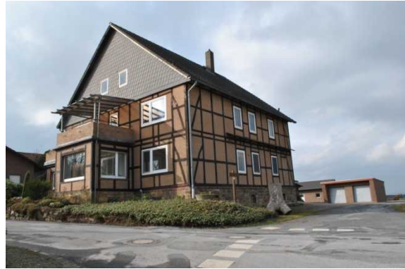
Ortsbildprägendes Gebäude in Friedrichswald
